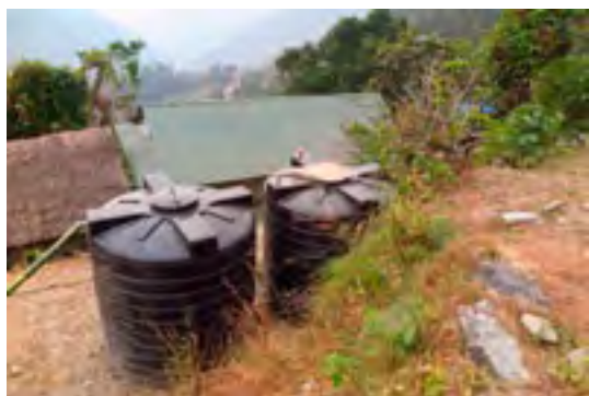
Le due cisterne a monte del villaggio
